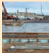
1階床土間工事
